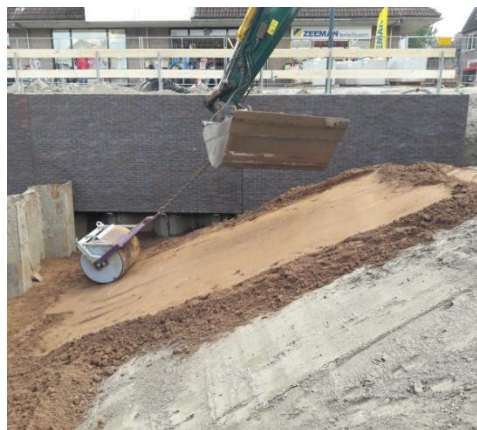
Aanbrengen trisoplast
