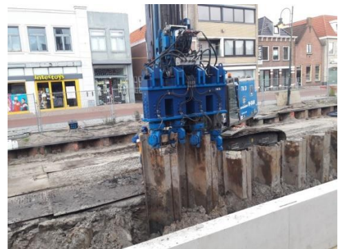
Verwijderen tijdelijke damwand
