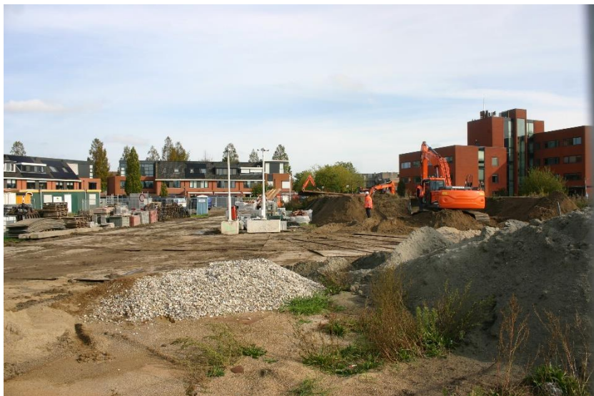
Figuur 4.1.5. Deelgebied 4; bouwplaats.
