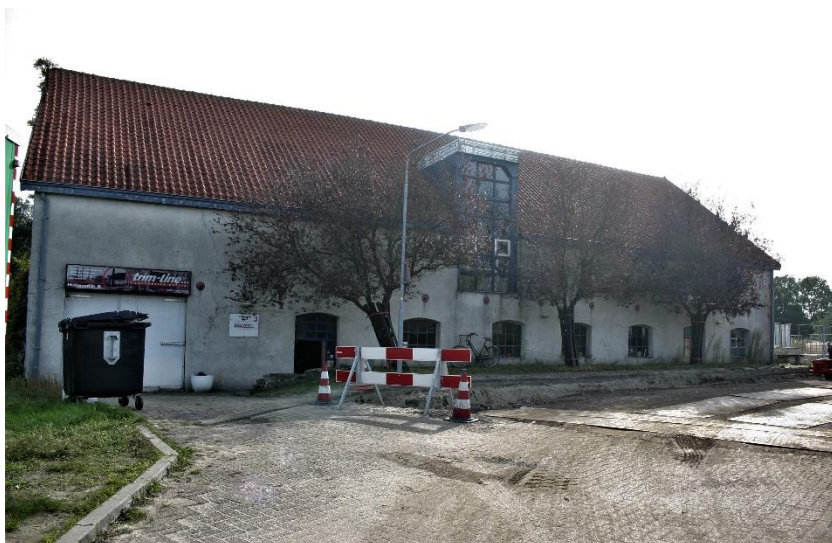
Figuur 4.1.4. Deelgebied 3; voormalige suikerfabriek aan Huizersdijk 3.
