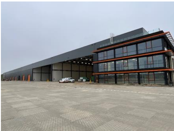
Bedrijfsloods met kantoor.
