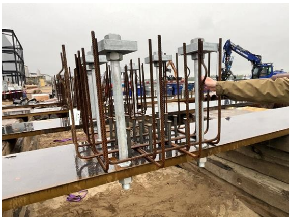
Industriële bolderconstructie voor kade in uitvoering.
